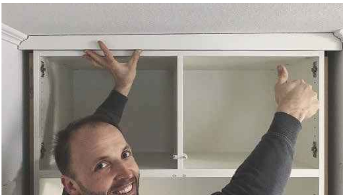
/ Auf das 3D-Aufmaß ist Verlass: Derksen und Winkler sind inzwischen so sicher im Umgang mit den Daten, dass sie selbst Passleisten auf Maß vorfertigen lassen.
